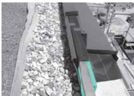
Топлоизолация на борд на плосък покрив
