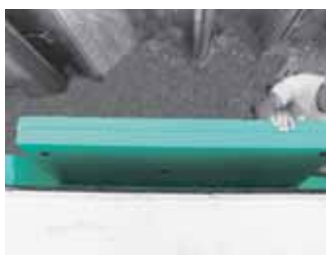
Закрепване на топлоизолацията със специалните лепящи ленти FIBRANstick
