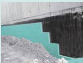
Топлоизолация на стени в основи
