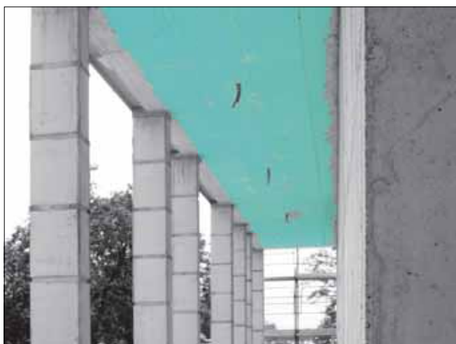
Топлоизолация на удължена покривна бетонна козирка – в процес на изпълнение
