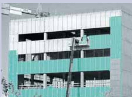
Окачена фасада с топлоизолация FIBRANxps
