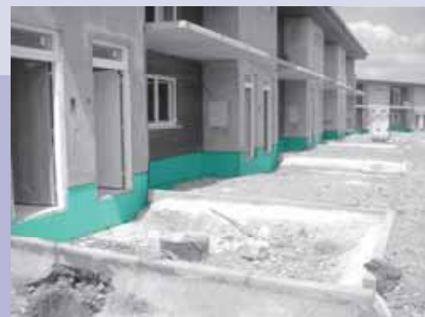
Топлоизолация на цокъл
