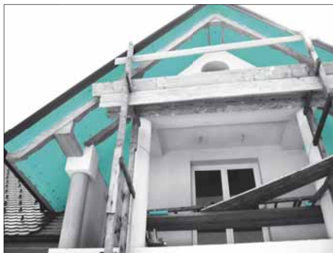
Полагане на плочи FIBRANxps ETICS на стреха
