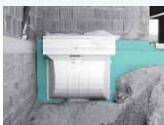
Топлоизолация при светлинна шахта в сутерен
