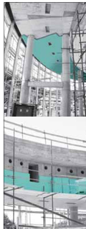
Полагане на FIBRANxps плочи върху бетонната конструкция на закрит плувен басейн
