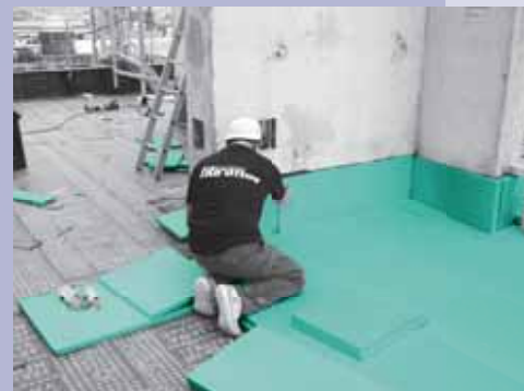
Топлоизолация на обърнат покрив (цокъл на комини, кули и др.)
