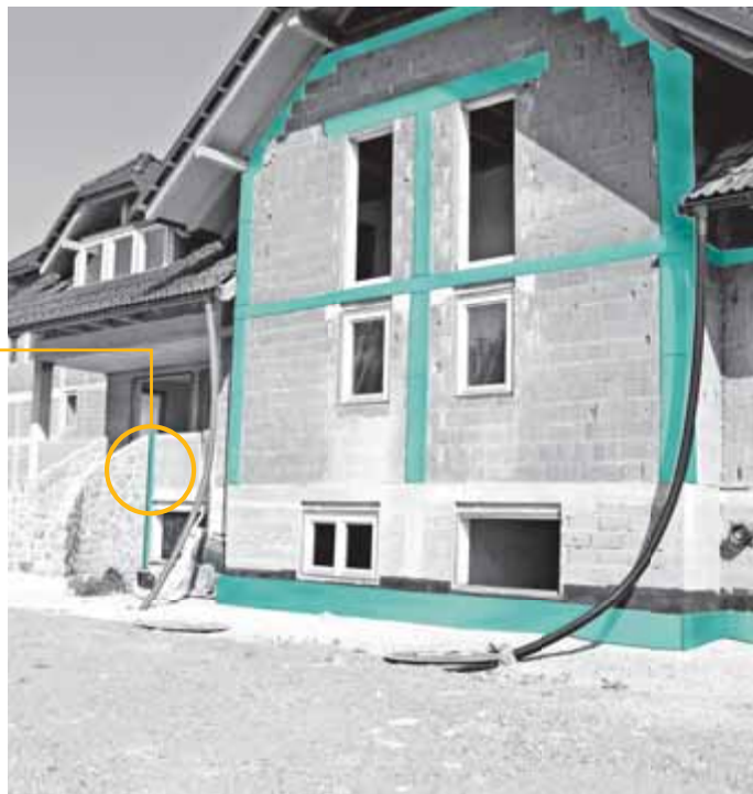
Топлоизолация на греди, колони, шурцове и цокъл
