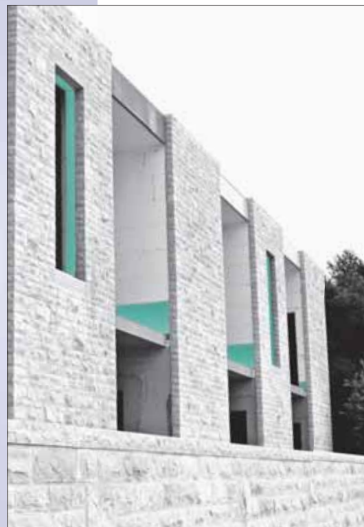
Каменна облицовка върху топлоизолация FIBRANxps ETICS
