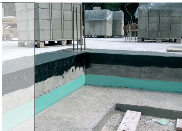
Топлоизолация FIBRANxps 400-L под фундаментна плоча.
