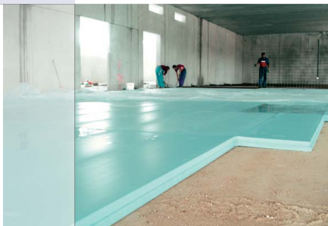
Детайл 5 – Топлинна защита на подова плоча в индустриални сгради с FIBRANxps 500-L. Ако повърхността е неравна, тя може да се нивелира с тънък слой пясък.
