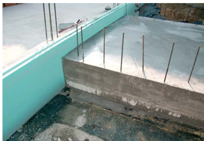
Необходимо е внимателно да се запечатат местата на закрепване на светлинната шахта. Частта от конструкцията, където се монтира светлинната шахта, трябва да бъде топлоизолирана.
