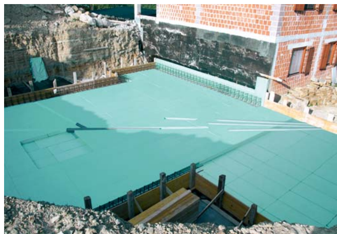
Монтиране на инсталации в предварително изрязани канали в FIBRANxps 400-L топлоизолационните плочи.
