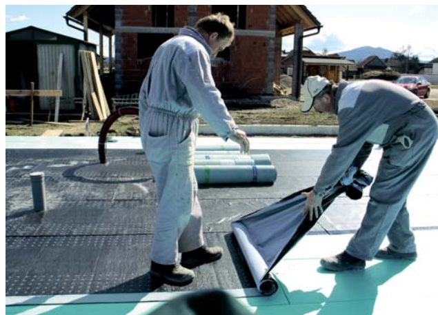
Полагане на самозалепваща хидроизолация върху топлоизолационни плочи FIBRANxps 400-L.
