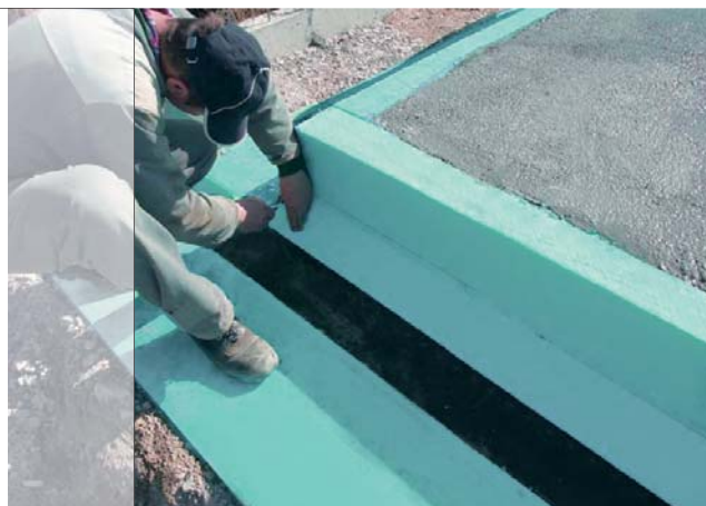
Детайли 9 - Хидроизолация между два слоя от FIBRANxps 400-L топлоизолационни плочи. Оформяне на вътрешните ъгли с битумна вертикална хидроизолация.
