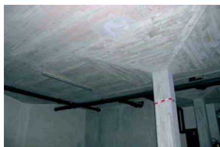
Последици: огромни енергийни загуби и липса на жизнен комфорт. В отопляемите помещения над студения сутерен са видими конденз и мухъл.
