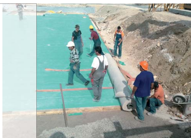
Детайл 8 – Хидроизолация с екологичен бентонит, поставен върху FIBRANxps 400-L преди изграждането на фундаментната плоча на училищна сграда.
