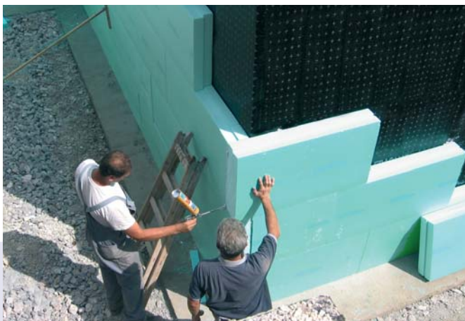
Връзки при монтирането на плочите FIBRANxps 300-L и съединяване на критичните точки при ъглите.
