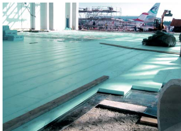
Топлоизолация под подовата плоча на самолетен хангар с FIBRANxps 700-L.
