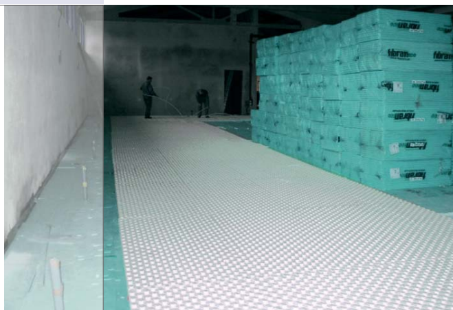
Детайл 5 – Топлинна защита на подова плоча в индустриални сгради с FIBRANxps 500-L. Ако повърхността е неравна, тя може да се нивелира с тънък слой пясък.
