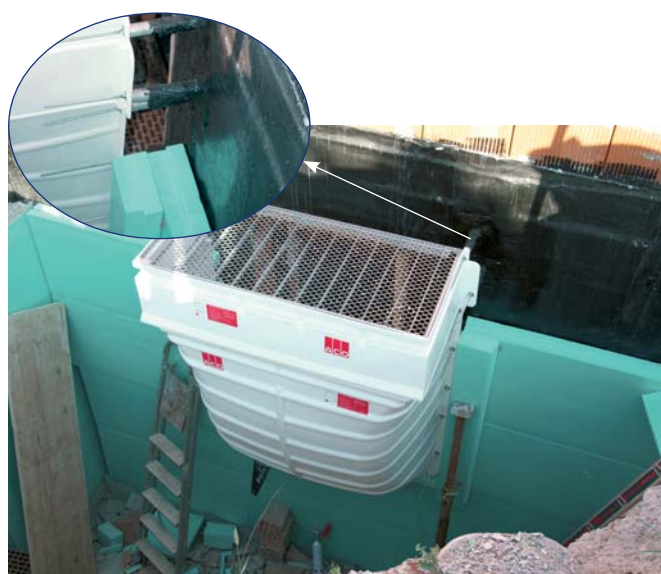
Необходимо е внимателно да се запечатат местата на закрепване на светлинната шахта. Частта от конструкцията, където се монтира светлинната шахта, трябва да бъде топлоизолирана.
