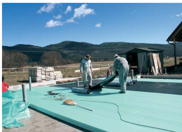
Самозалепваща хидроизолационна мембрана, поставена между два слоя топлоизолация FIBRANxps 400-L.
