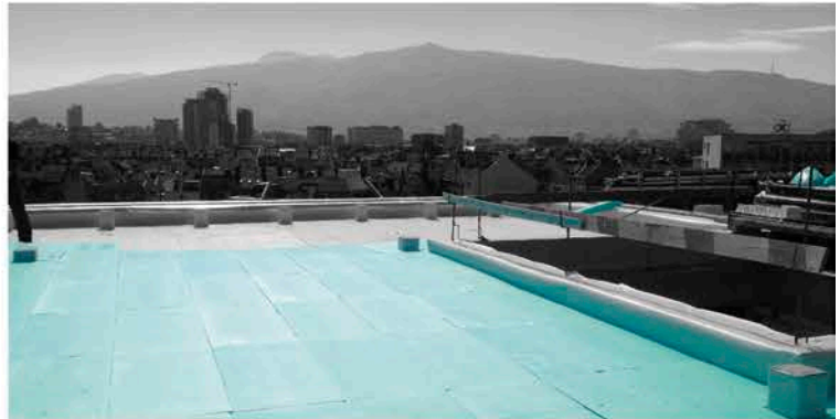
Полагане на FIBRANxps 300-L видима топлоизолация, предпазваща помещенията от свръхпрегреване през лятото и прекомерно изстудяване през зимата
