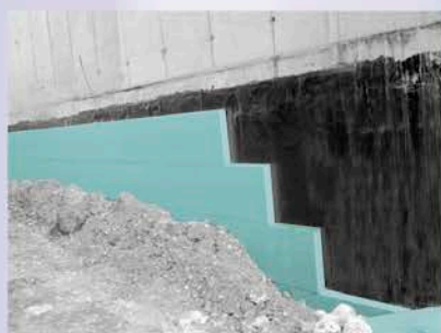
FIBRANxps 300-L за механично предпазване на хидроизолационната мембрана и едновременно теплоизолационна защита на основите
